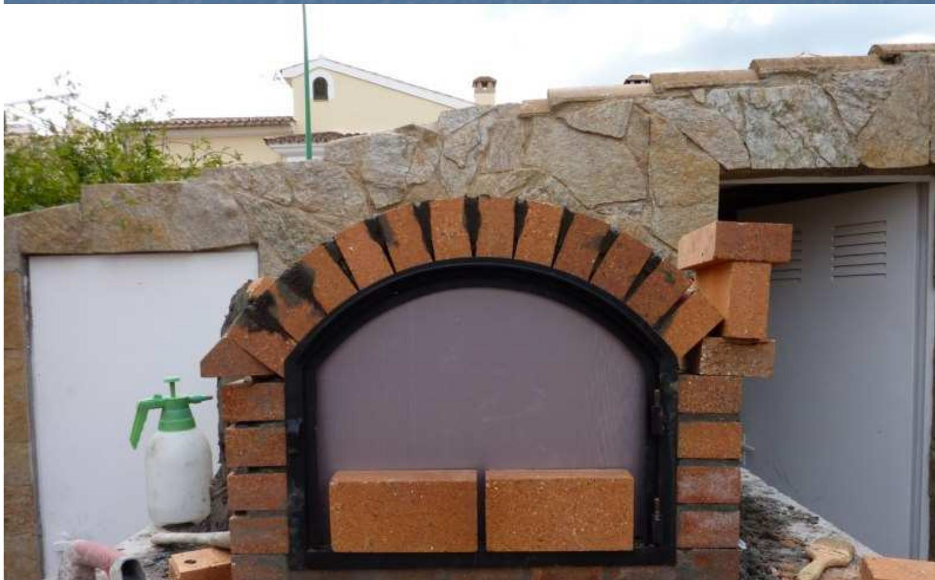
Aquí se puede ver la parte trasera, con la plantilla trasera de la puerta que es la que aguanta los ladrillos mientras se seca el cemento
