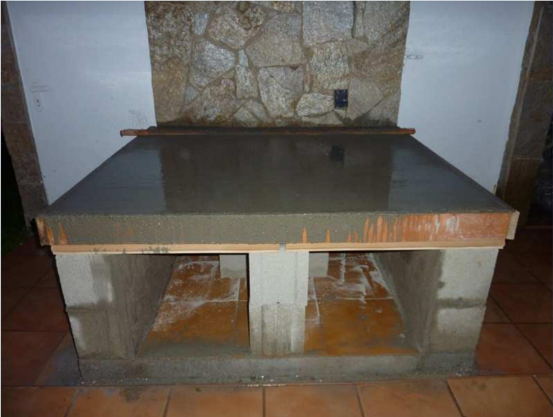
Coloqué el molde del horno, lo posicioné y lo marqué.... De esta manera es posible hacer coincidir la hornilla con el horno., en su parte trasera
