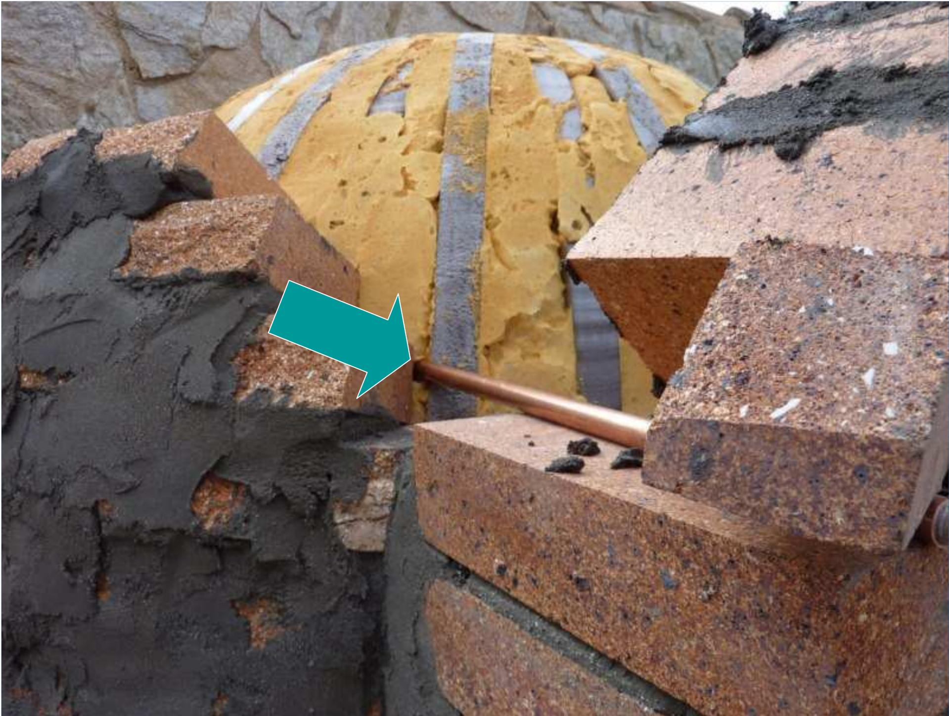
Hay que dejar el hueco entre la parte trasera de la puerta y el molde, para a colocación de la chimenea
