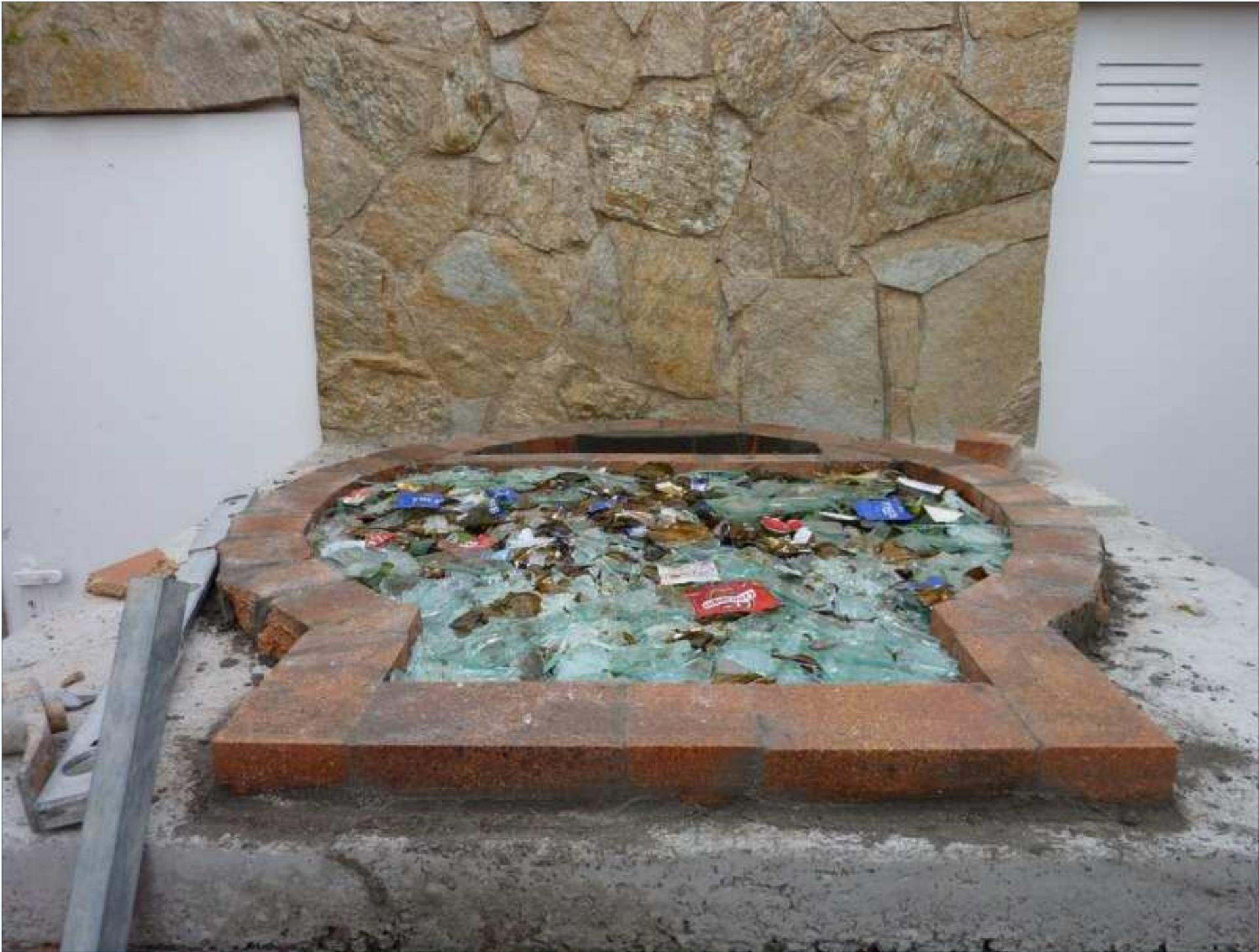
Luego rellené con sal el interior, sobre los cristales y posteriormente coloqué los ladrillos para la base del horno, los ladrillos que coloqué sobre la sal, van simplemente sobre ella, sin ningún tipo de cemento, los que van sobre el borde, los coloqué con cemento refractario. Dejé juntas entre los ladrillos, que luego rellené con refractario.
