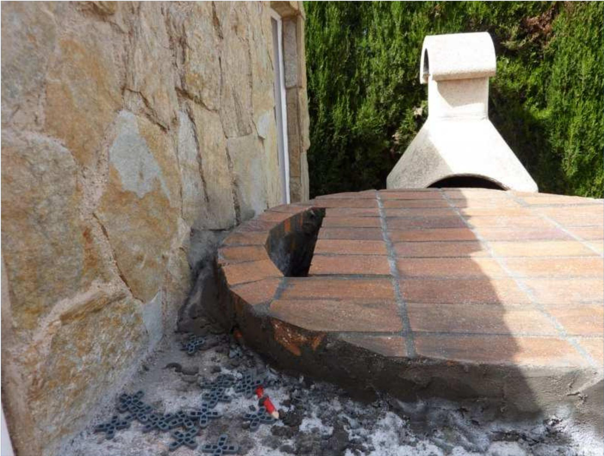
Luego coloqué el molde del horno, posicioné la puerta del mismo, y comencé a colocar los ladrillos alrededor, aprovechando el molde, la colocación es más rápida y fácil, que si lo hacemos con una cuerda guiándonos con los nudos.
