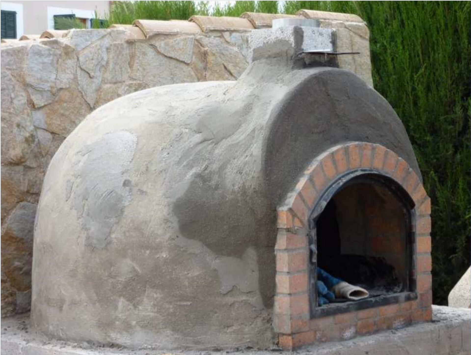
Luego como compré dos sacos de mortero impermeable blanco, los use y le di tres capas, luego en la parte inferior forré las paredes con piedras.
