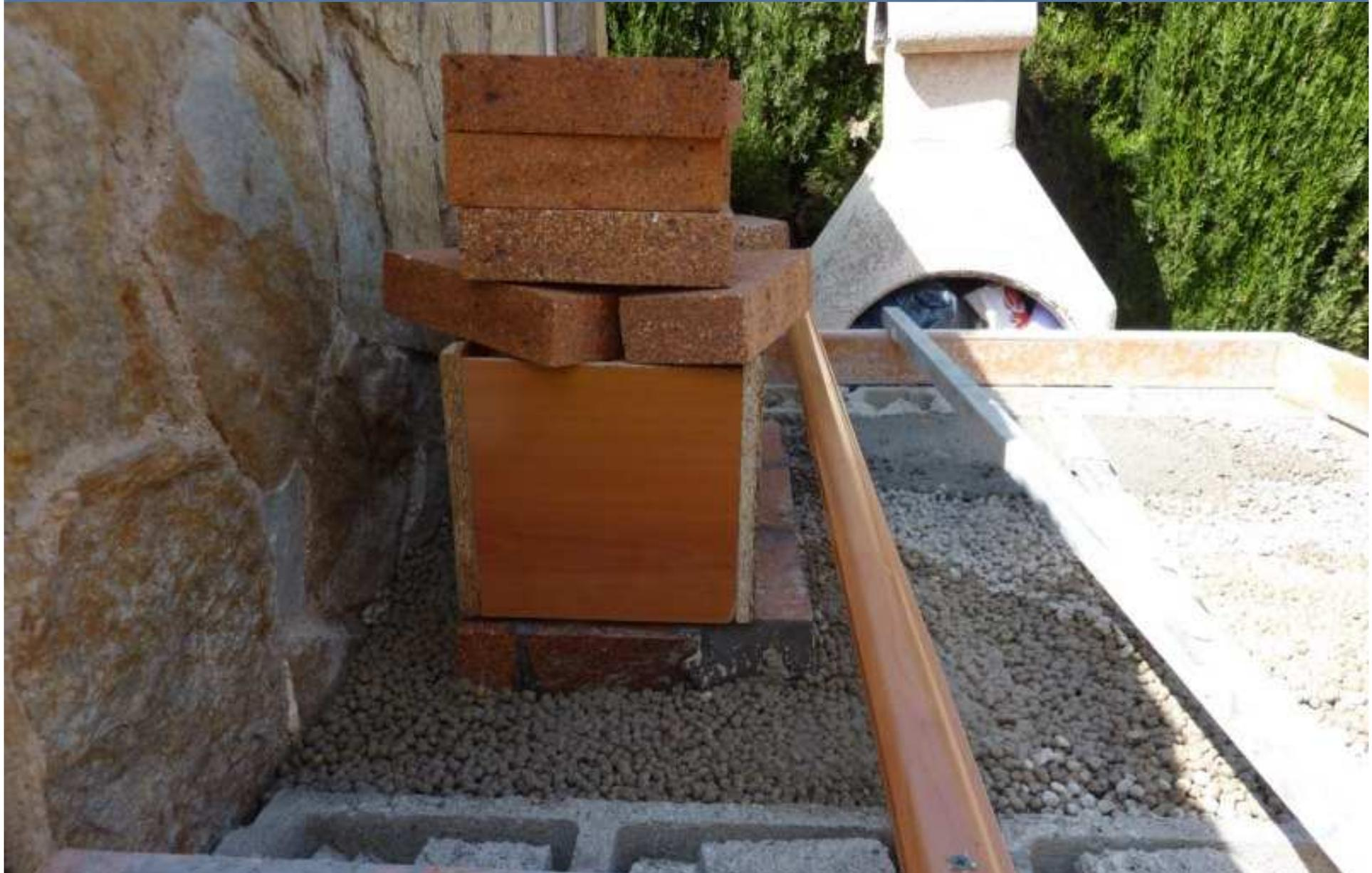
Preparé el encofrado para el horno, con la rejilla correspondiente, y lo rellené de hormigón
