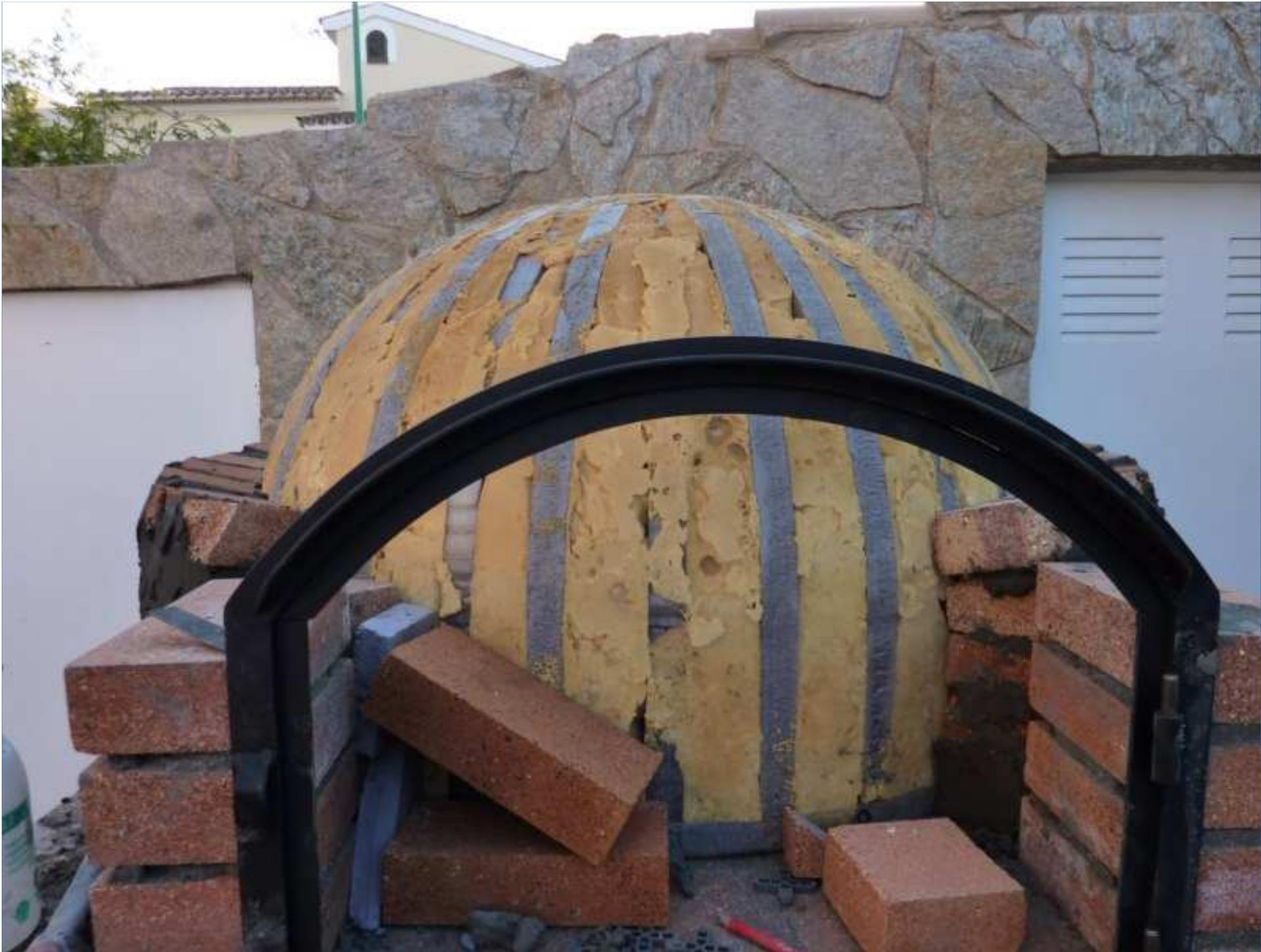
Aquí se colocaron los ladrillos superiores de la puerta del horno
