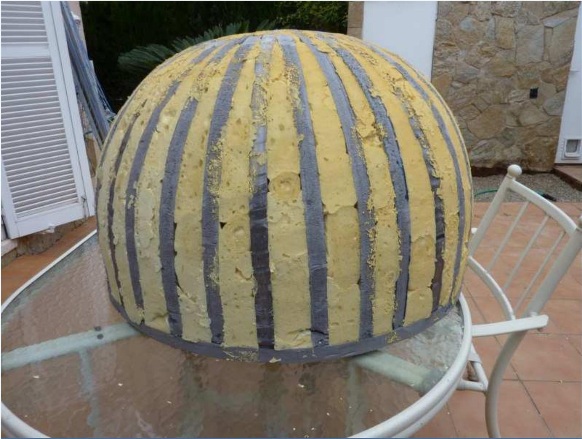
El horno que he hecho, lo he construido con hornilla, por lo cual siguiendo el procedimiento anterior, hice una plantilla, y recorte varias piezas, y con los restos de los recortes la fui pegando, hasta tener el molde del interior de la misma. (NOTA: el molde de la hornilla fue usando las medidas del ladrillo reflectarlo 22x11x5, RENOTA: cuando compre los ladrillos estos eran de 20x10x5, RERENOTA: Pues hice otra plantilla, pero con conglomerado.... Que se le va ha hacer...
