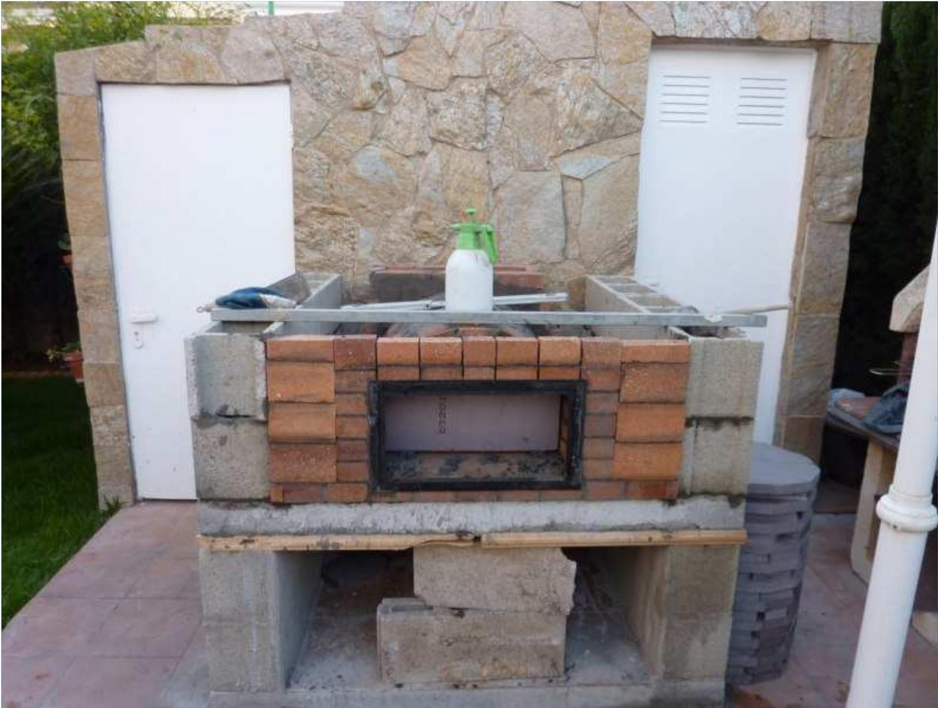
Con argila expandida, un poco de arena y cemento refractario, hice hormigón y rellené la base alrededor de la hornilla, consiguiendo aligerar el peso, además de ser un excelente aislante de el calor
