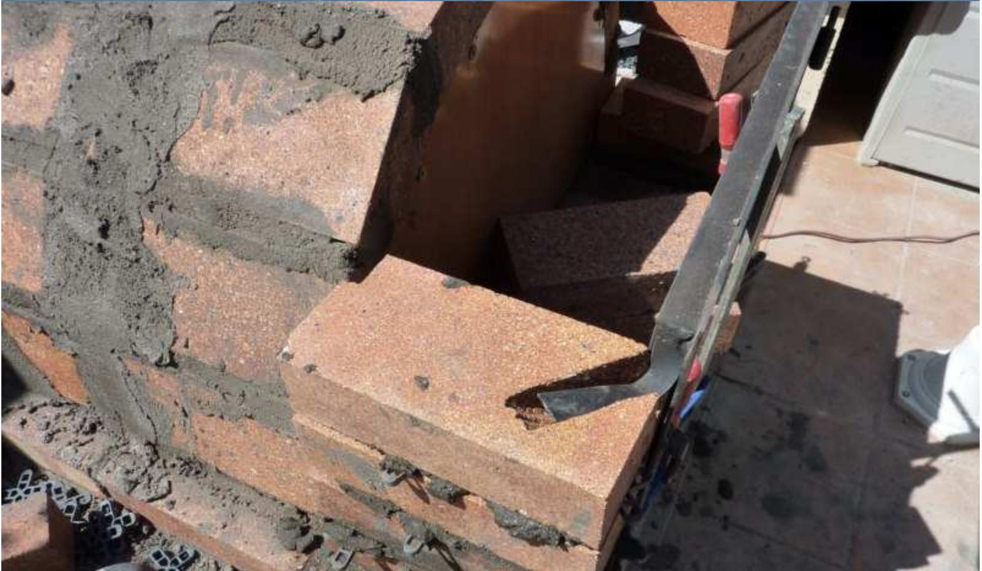
Corté una plancha de poliestireno, de las mismas dimensiones que el interior del marco de la puerta de la hornilla, el cual me sirvió como soporte de los ladrillos colocados en la parte superior...
