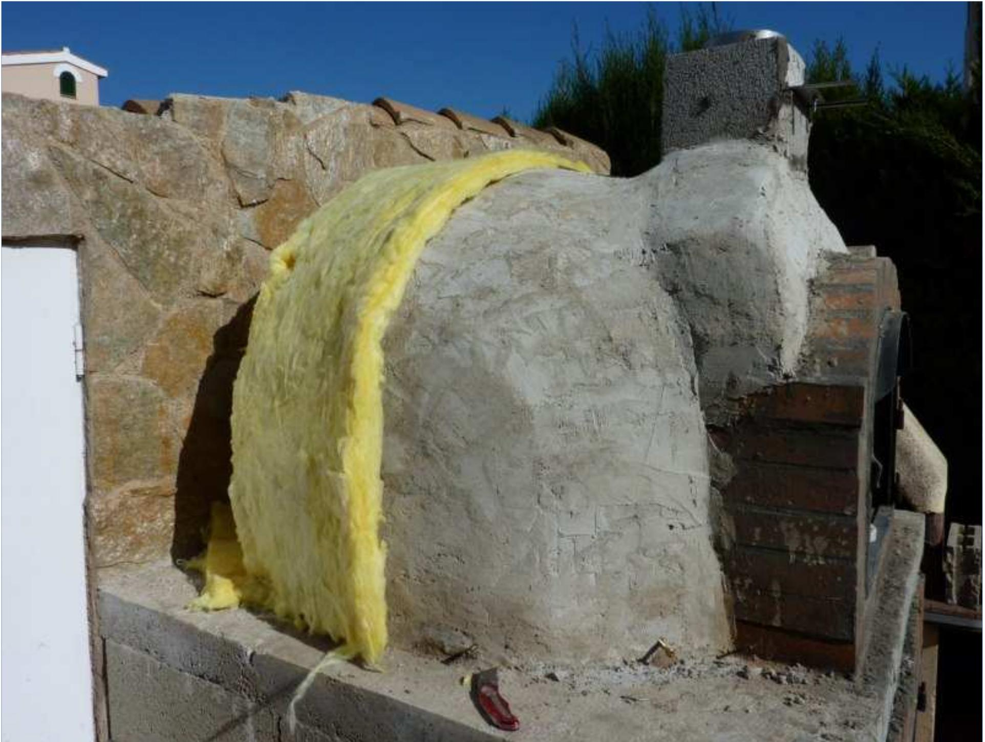
Una vez posicionada la lana, coloqué una malla de metal, que es la que servira de agarre a las capa de mortero reflectante que se le da posteriormente., todo se sujeta con alambre
