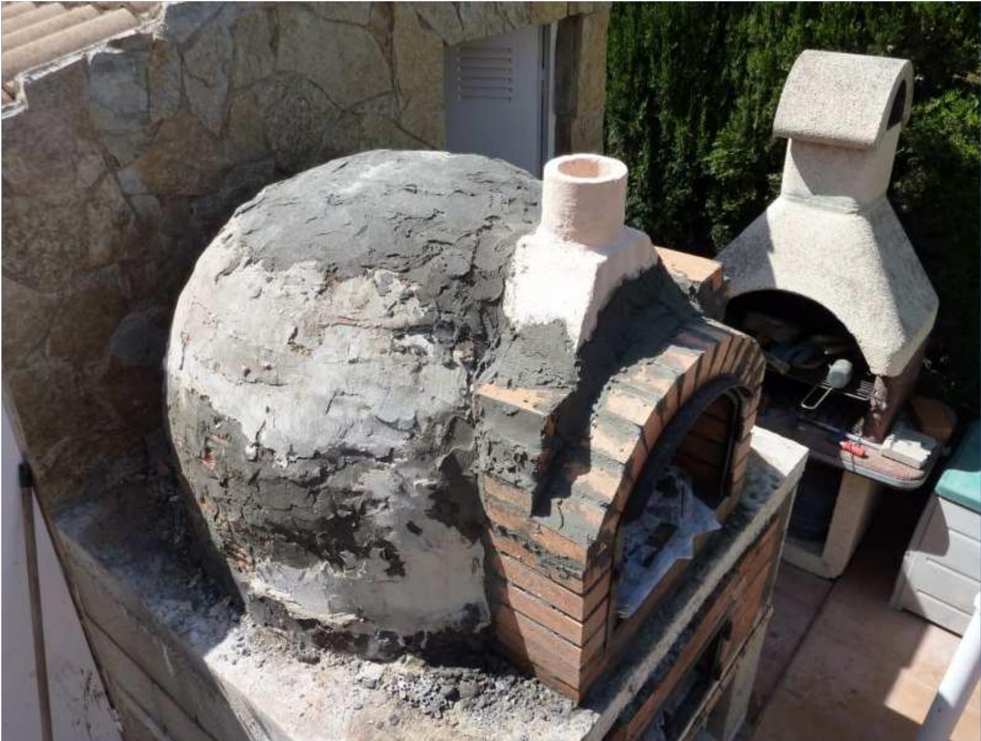
Después le coloqué el tiro de la chimenea, y a su alrededor un bloquillo cuadrado, Cortando la parte delantera en dos mitades, para enjacar el tiro de la misma.
