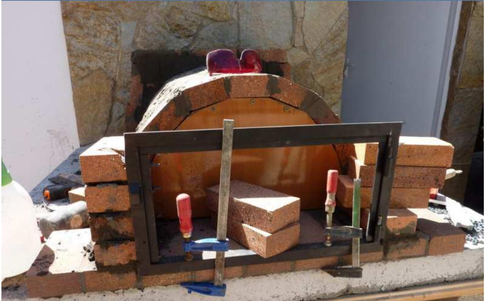
Las patillas para el anclaje de la puerta hay que levantarlas, doblarlas y girarlas con unos alicates o tenazas, y luego hacer un rebaje en el ladrillo para que quede introducida....
