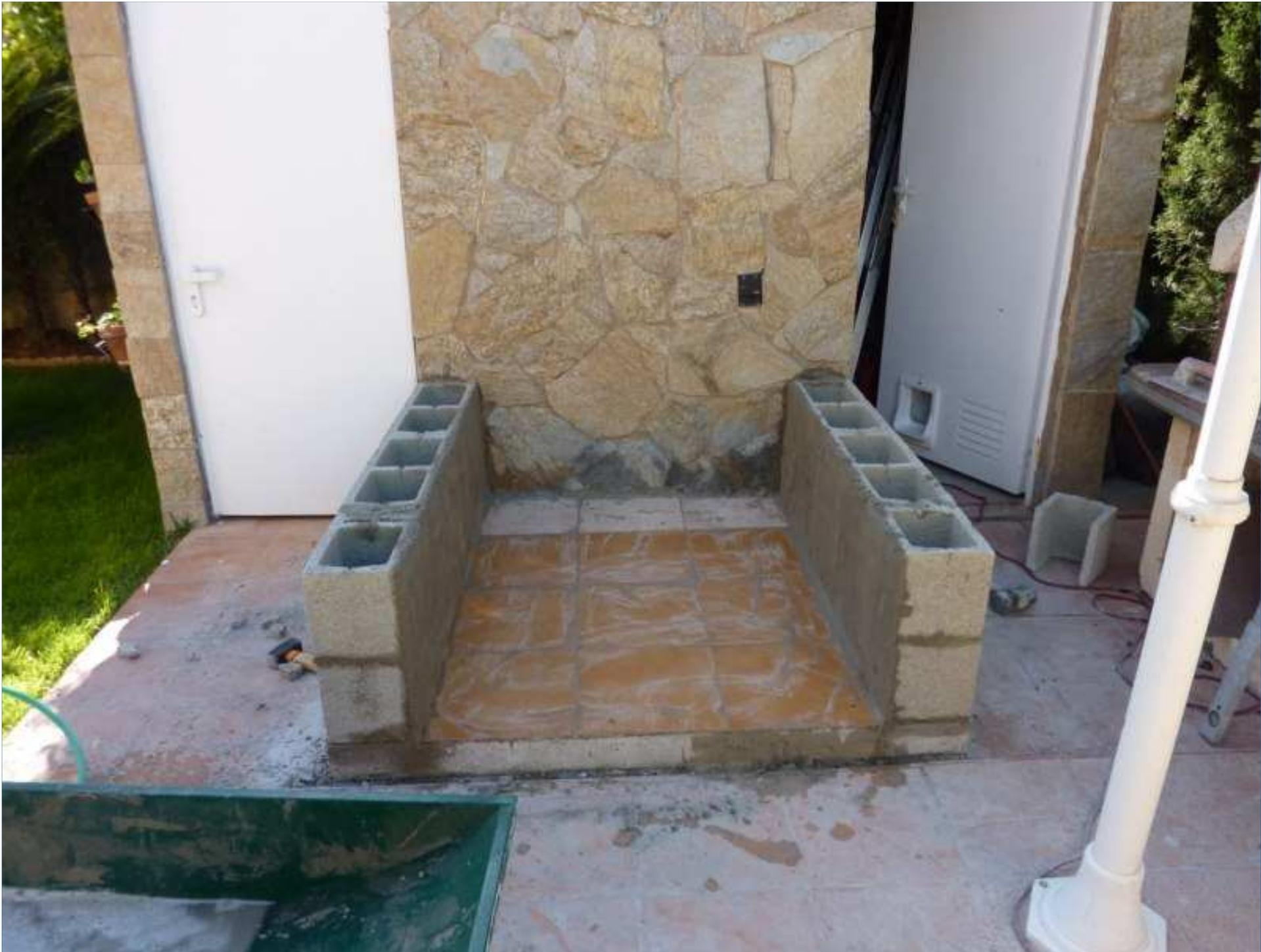
Preparé la base, con bobadillas, madera para el encofrado y rejilla para hormigón....
