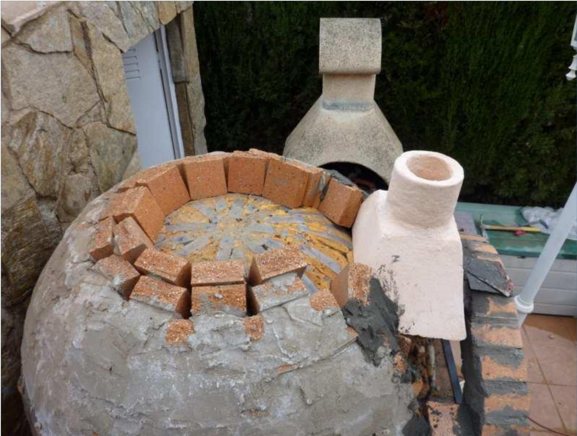
Terminamos de colocar los últimos ladrillos, ajustando la chimenea con ladrillos, hasta quedar totalmente tapada, luego le di una capa de mortero reflectario a toda la cúpula
