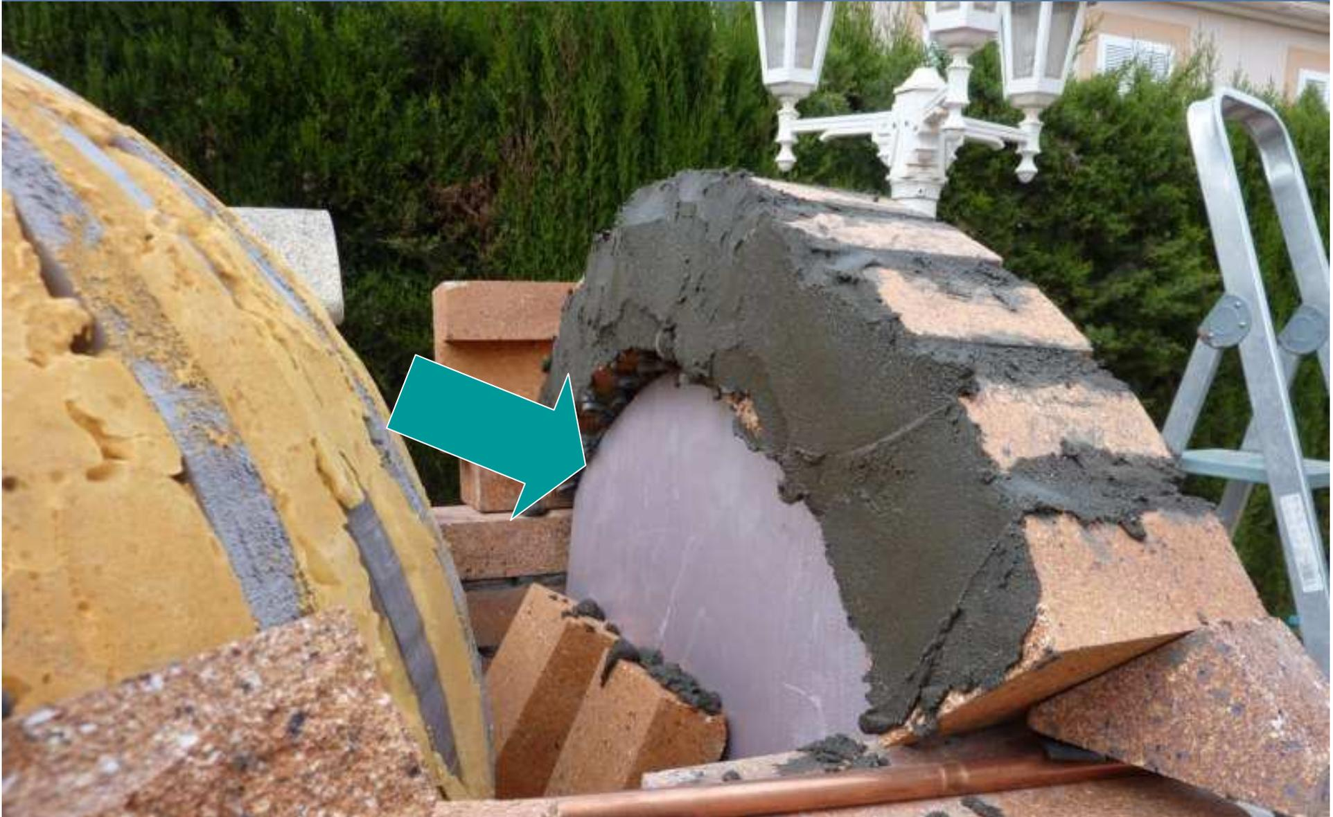
Aquí se observa la colocación del tubo de cobre para el pirómetro
